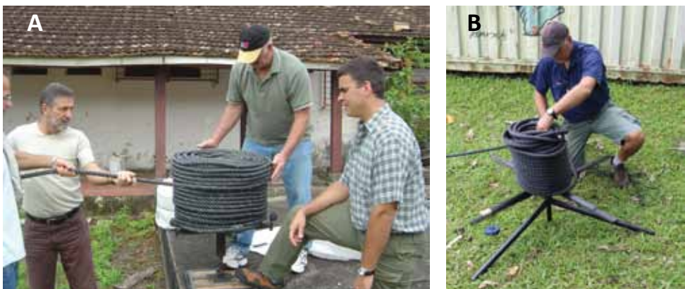
Figura 14. Desenrolando a bobina de cabo com o auxílio de: (A) cadeira giratória colocada de ponta cabeça e (B) suporte giratório de aço.
